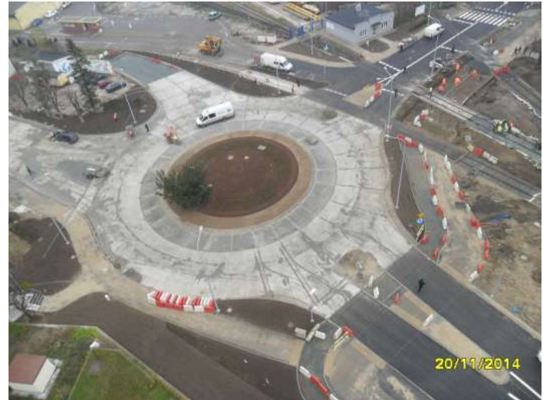
Zdjęcie: własność BUDPOL Sp. z o.o., betonowanie: BUDPOL Sp. z o.o., nacinanie: REKMA Sp. z o.o.
