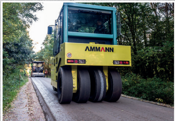
Budowa drogi leśnej w m. Bartniki (woj. mazowieckie) 2017 r.
