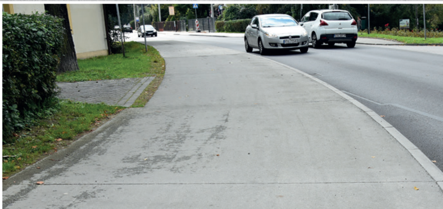
Ciągi pieszo-rowerowe z betonu wałowanego w Skawinie (woj. małopolskie)
