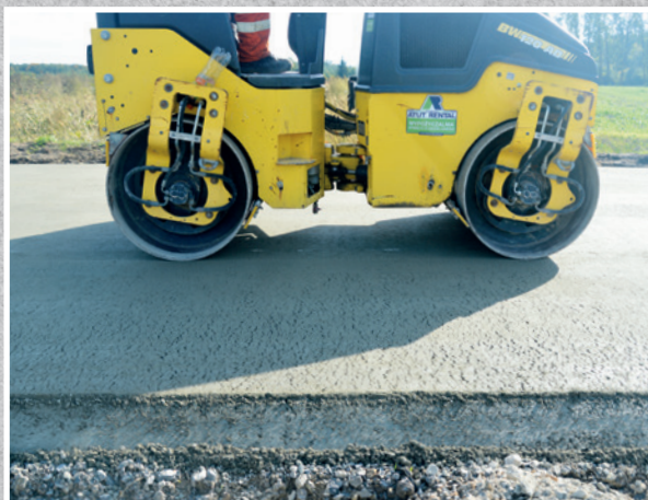
Technologie: beton wałowany RCC
