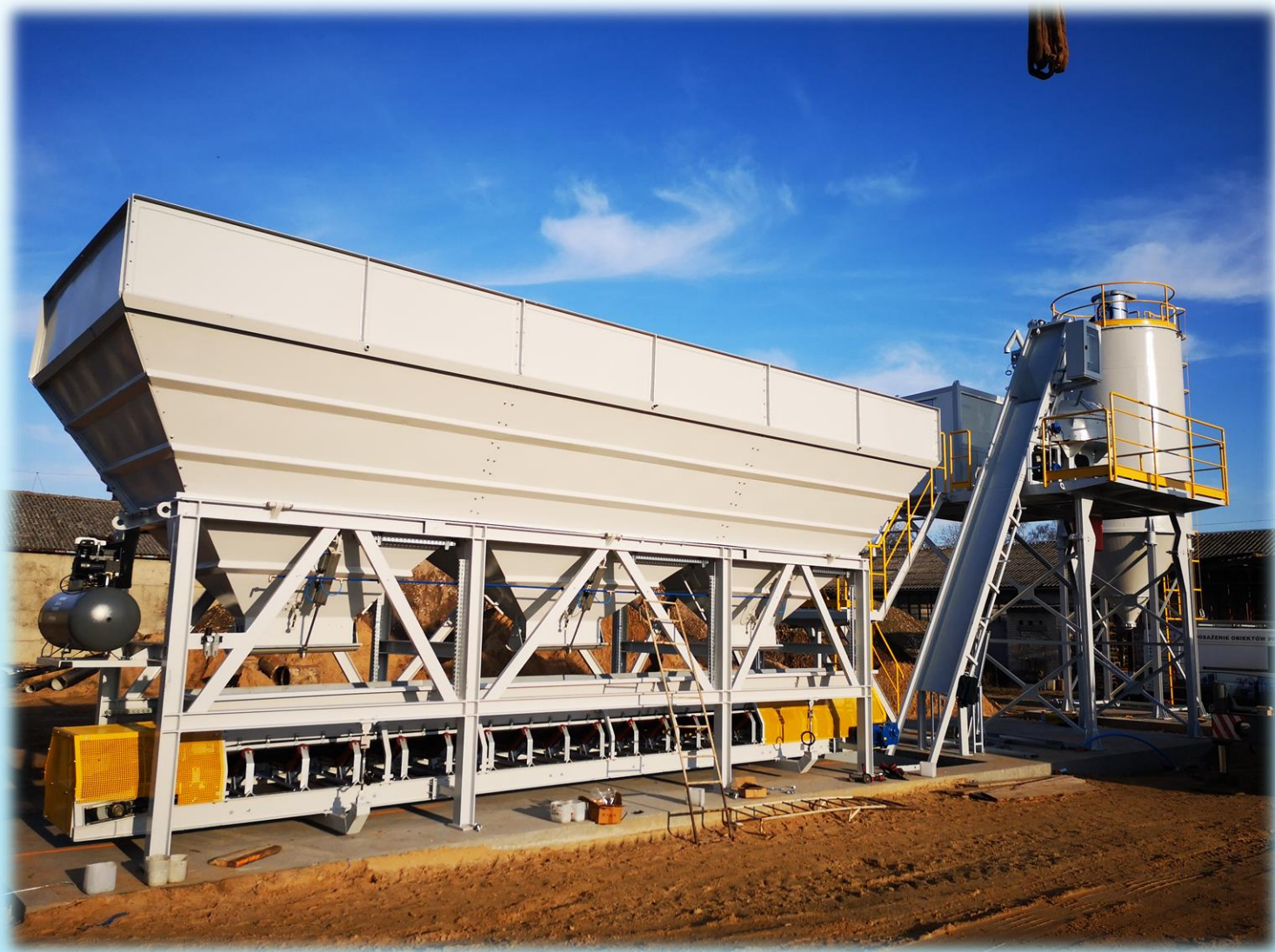
Węzeł do produkcji betonu
