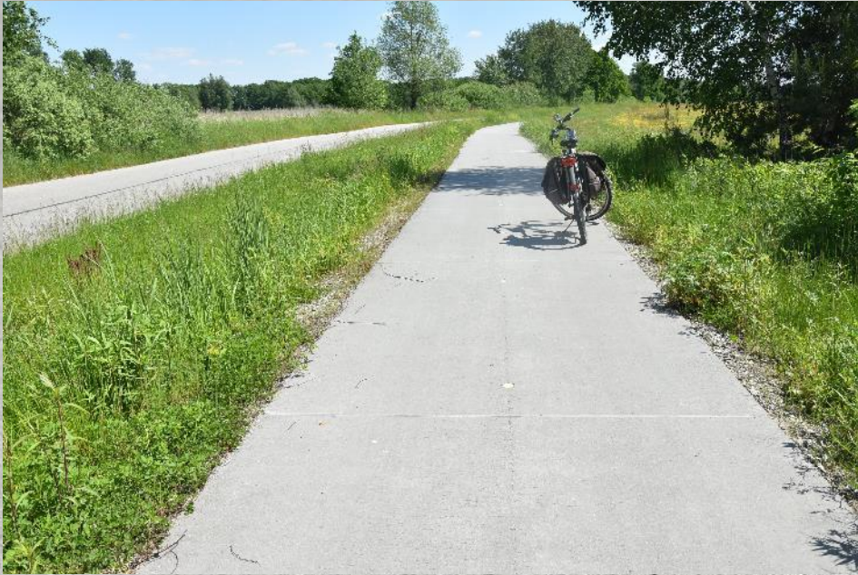
4,6 km ścieżek rowerowych z betonu wałowanego na terenie gminy Żmigród
