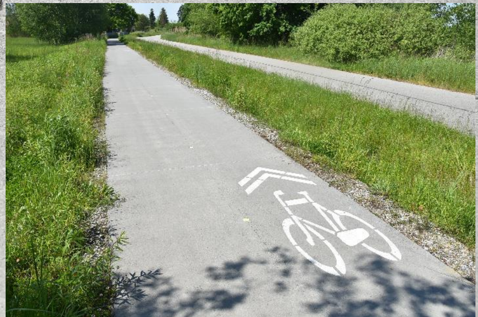
4,6 km ścieżek rowerowych z betonu wałowanego na terenie gminy Żmigród
