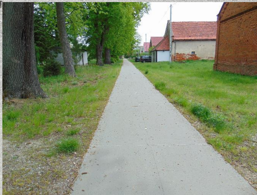
Nawierzchnia z betonu wałowanego ma 12 cm grubości i 2,2 m szerokości
