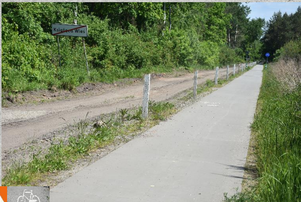
Nawierzchnia z betonu wałowanego ma 12 cm grubości i 2,2 m szerokości
