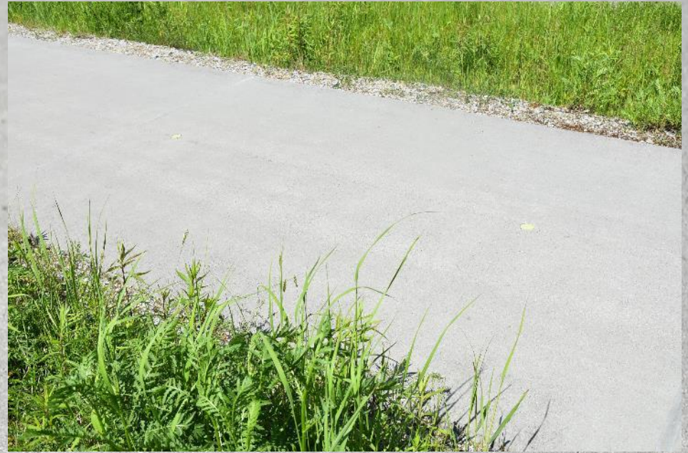
4,6 km ścieżek rowerowych z betonu wałowanego na terenie gminy Żmigród
