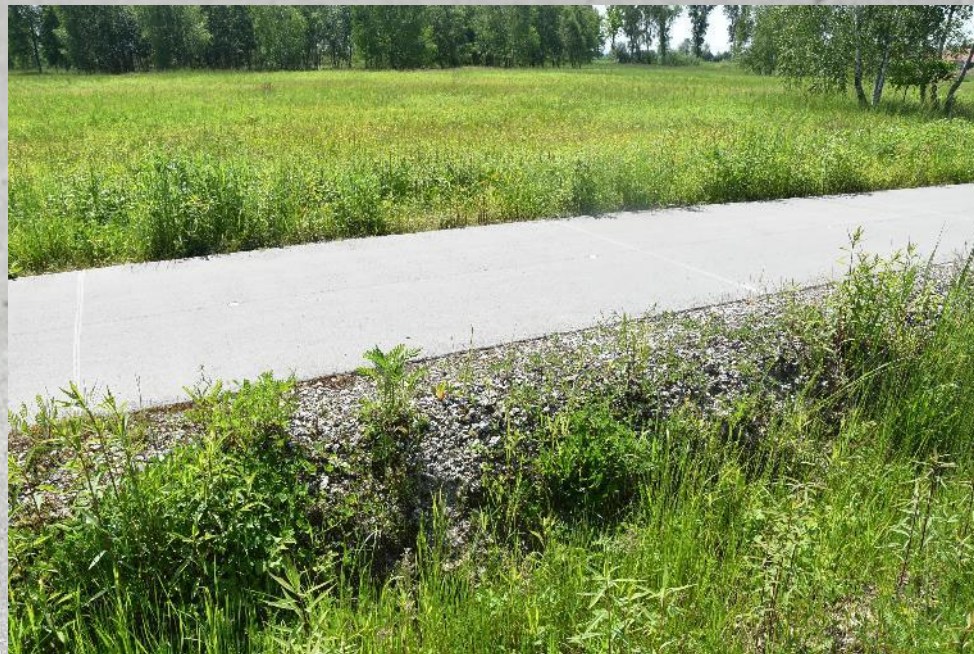
Nawierzchnia z betonu wałowanego ma 12 cm grubości i 2,2 m szerokości
