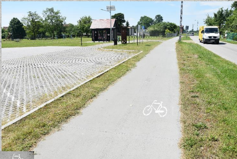
4,6 km ścieżek rowerowych z betonu wałowanego na terenie gminy Żmigród
