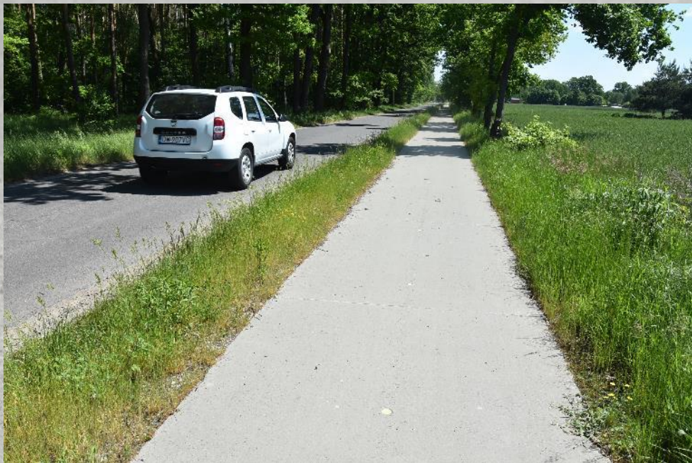
Nawierzchnia z betonu wałowanego ma 12 cm grubości i 2,2 m szerokości
