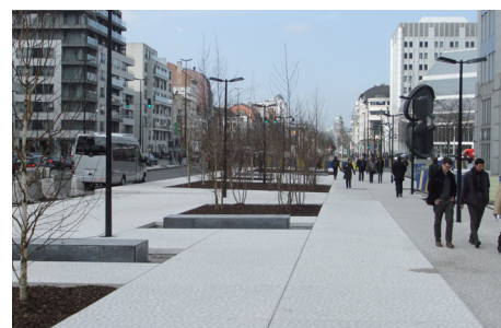
Bruksela, Plac Rogier © L. Rens / FEBELCEM
