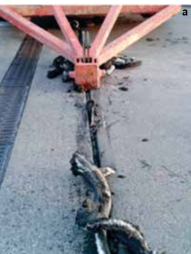
Fot. 12 (a-f). Wizualizacja technologii wymiany masy uszczelniającej w szczelinach nawierzchni betonowej. Zdjęcia OAT Sp. z o.o.
