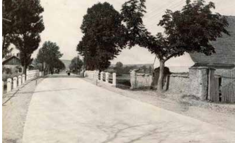
Fot. 2. Widok drogi krajowej o nawierzchni z betonu cementowego w pobliżu Skoczowa, rok 1935 [3]
