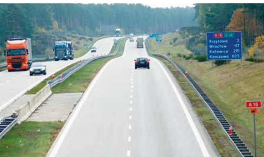
Fot. 9. Widok nawierzchni drogi krajowej nr A18 (wcześniej A12) z betonu cementowego po 20 latach eksploatacji. Zdjęcie wykonane przez Marka Stańczyka w październiku 2015
