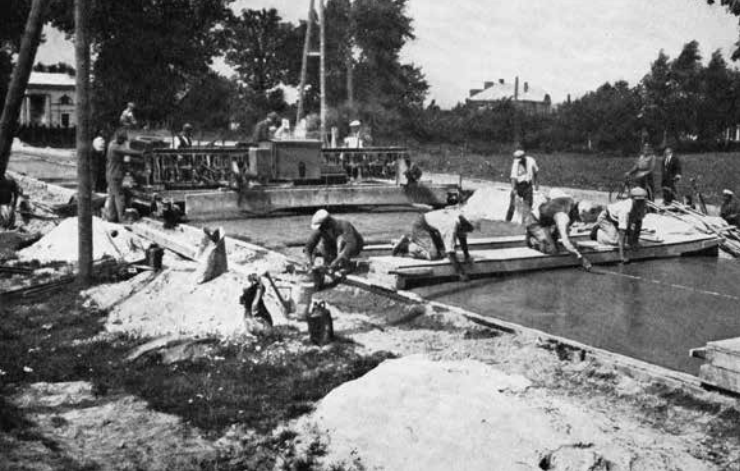
Fot. 1. Budowa drogi o nawierzchni betonowej na odcinku drogi krajowej Warszawa – Modlin, rok 1935 [3]. Źródło: Aleksander Kobylński, „Die Landstraßen in Polen” miesięcznik „Die Straße”, rocznik 2, nr 17 z 1 września 1935 roku
