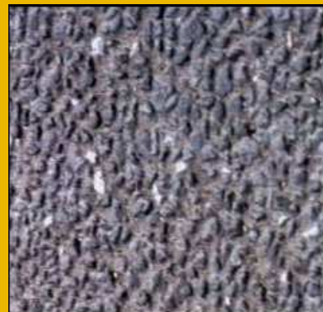
Nawierzchnia GWB 8, Austria
