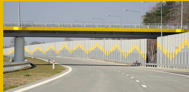
S-8, Odcinek VIII, Węzeł Róża - Wrocław 2011-2014
