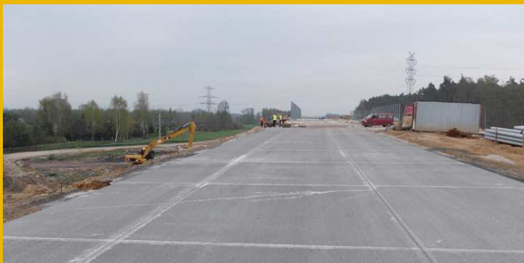
S-8 Odcinek VIII, Węzeł Róża-Wrocław 2011-2014
