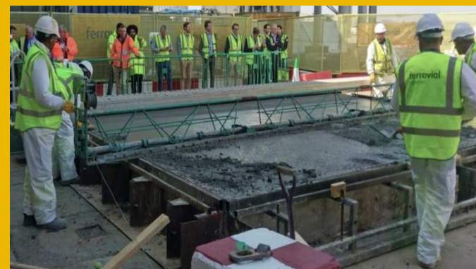
Lotnisko Londyn Heathrow 2017 układanie ultra szybkiego betonu
