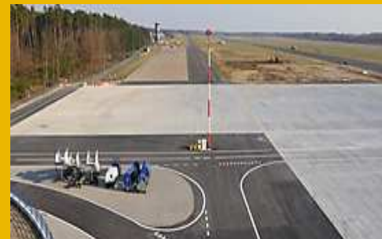
Lotnisko Goleniów Betonowa nawierzchnia PPS
