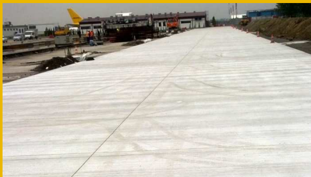
Lotnisko Okęcie Warszawa Betonowa nawierzchnia PPS
