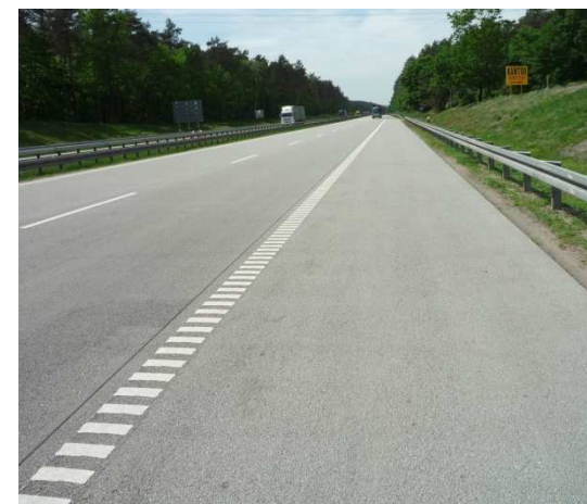
Płyta zbrojona bez szczelin dylatacyjnych na podbudowie z chudego betonu (A4, A2)
