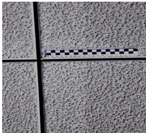
Płyta za szczelinami dyblowanymi na podbudowie z chudego betonu (A4, A2, S8)
