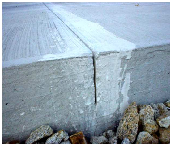
Płyta za szczelinami dyblowanymi na podbudowie z kruszywa (A4)
