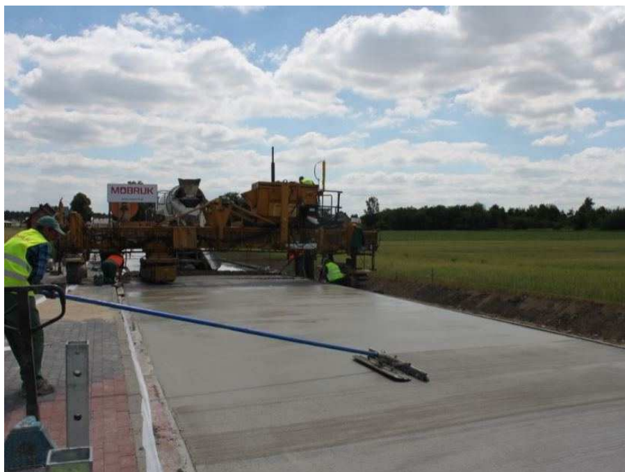
Teksturowanie nawierzchni – szcztokowanie poprzeczne
