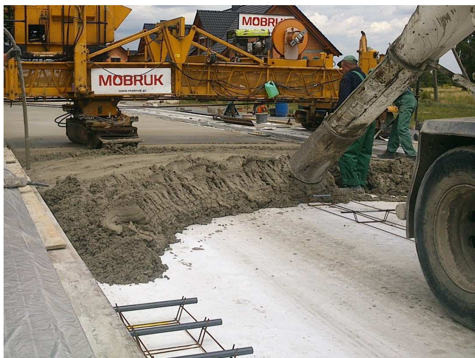
Warstwa poślizgowa z geowłókniny
