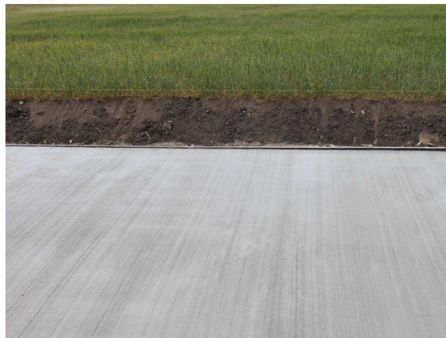
Tekstura, świeży beton
