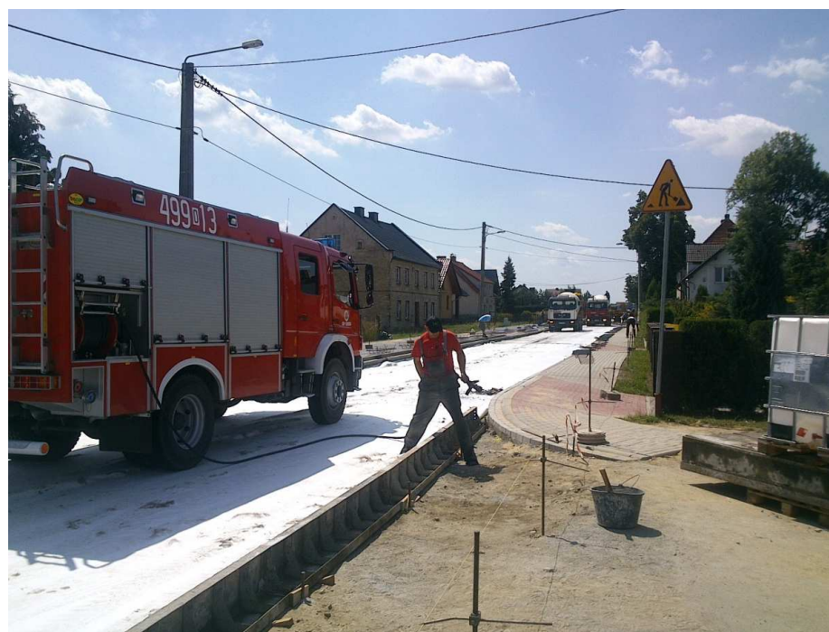
Zwilżanie geowłókniny wodą
