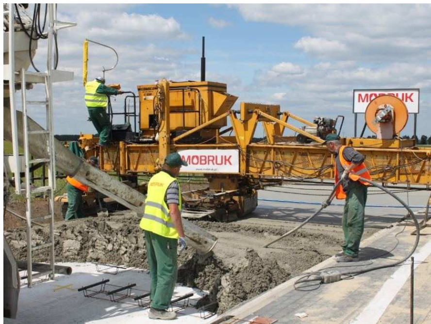
Wbudowywanie dybli, zagęszczanie betonu
