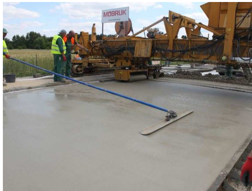
Zacieranie/wygładzanie nawierzchni, szalunki stałe (krawężnik)
